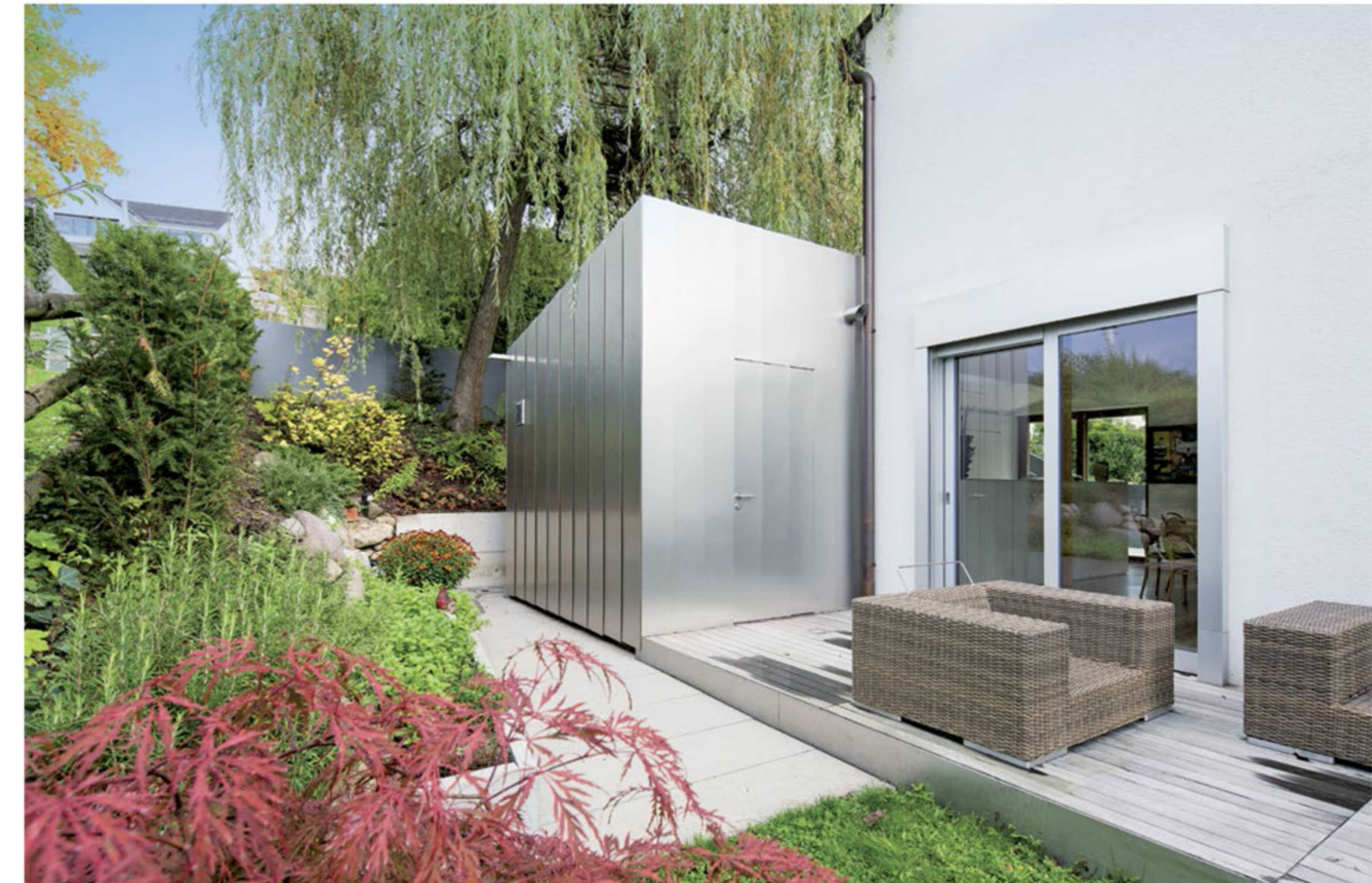
Der vorkragende Anbau schützt den in Richtung Westen entstandenen Freisitz.
